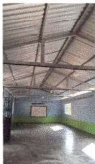
Foto 1: Sustitución de lámina por lámina troquelada aluzinc calibre 26 y sustitución de estructura de soporte de madera, por soporte de metal módulo 1
