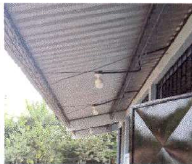
Foto 2: Reparación del Sistema Eléctrico módulo 1
